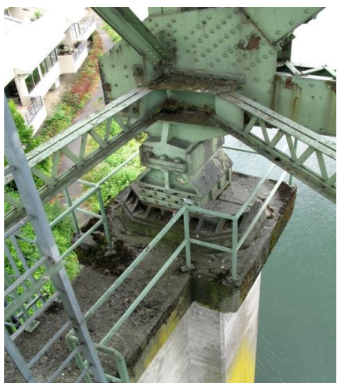
Fig. 11. Bearing, Pier 17.
