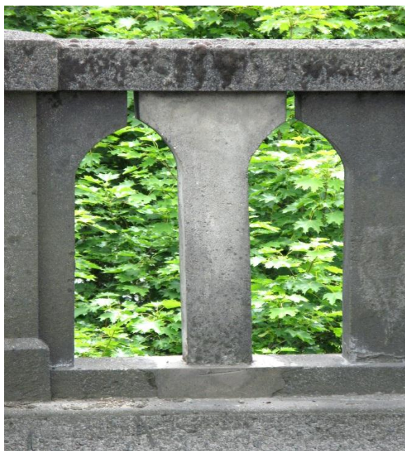
Fig. 23. Repaired Baluster
