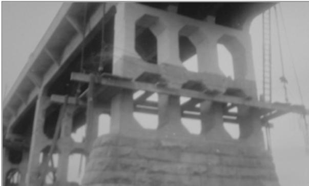
19. Travaux de réfection sur les piliers en béton vers 1954. Source : © MTQ.
