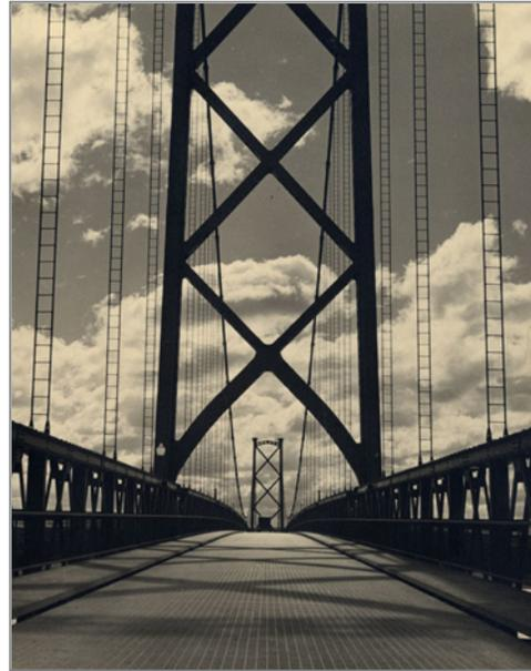
17. Cette photographie d'époque démontre le grillage métallique sur la chaussée du tablier du pont. Source : © BAnQ, vers 1940.
