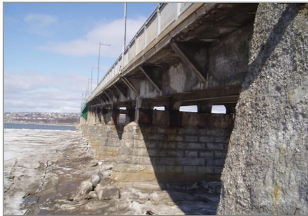
25. Piliers en maçonnerie du pont de l'Île-d'Orléans. Source : © MTQ.
