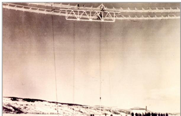
29. Le pont en construction, 1935. À partir du fleuve gelé, des pièces du tablier sont soulevées jusqu'aux câbles principaux. Source : © Collection Suzie Gourdeau.
