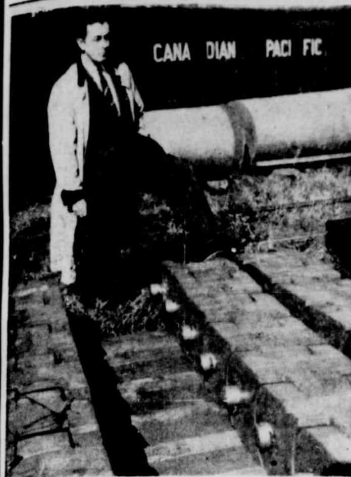
M. HARRY ROBERTS, gérant de Canada Iron Foundries, près des chaînes géantes qui serviront de contrepoids dans le procédé d'élévation des travées centrales des ponts sur le canal Beauharnois. Chaque maille de la chaîne pèse 300 livres.
