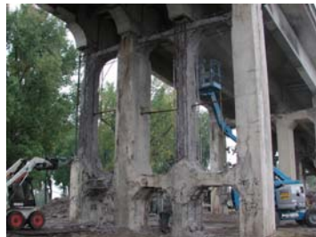
Pendant les travaux
