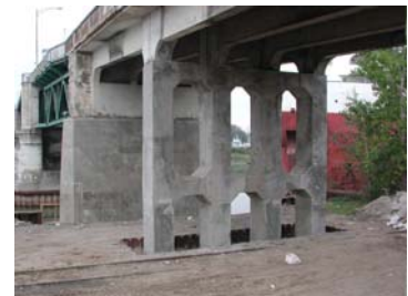
Après les travaux
