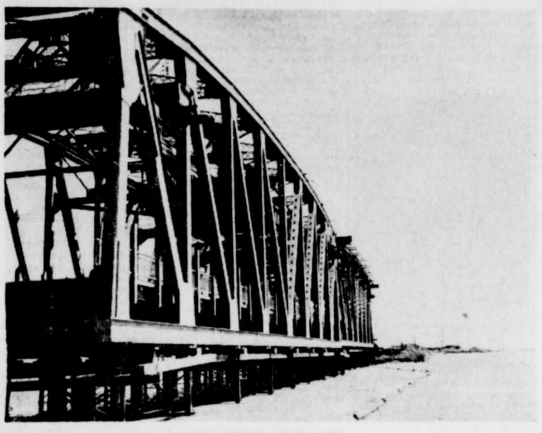
CHACUNE DE CES TRAVÉES à 220 pieds de longueur et sera transportée à compter d'aujourd'hui sur des chalands remplis d'eau. Au moment de la mise en place, on pompe l'eau graduellement pour faire remonter la section au niveau des travées d'approche. Ces travées ont été construites par Dominion Structural Steel. Le mécanisme, fabriqué par Canada Iron Foundries, sera installé au sommet de ces travées. Deux tours de 170 pieds de hauteur sont érigées à chaque extrémité. C'est aujourd'hui même qu'on commencera les opérations délicates consistant à remplacer l'ancienne travée par la nouvelle.
